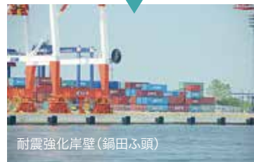
耐震強化岸壁(鍋田ふ頭) 飛鳥ふ頭南側CT2バース(全長750m) 鍋田ふ頭CT2バース(全長635m)
