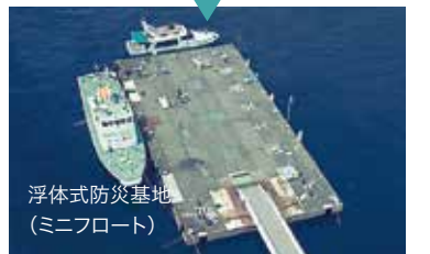
浮体式防災基地(ミニフロート) 浮体式防災基地(ミニフロート)2基
